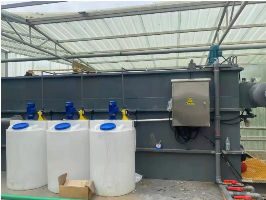
实验室废水处理设备主要是由废水处理单元，调节单元，深度处理单元，沉降分离单元，物理处理单元，生物处理单元，综合废水净化处理等多个单元所组成。通过各种处理技术，对实验室中生产出的有机，无机，综合废水等进行处理。含有的COD[BOD]SS[色度]以及重金属等离子都可以有效去除。根据废水的不同性质，可采用不同的技术方法垃圾处理。实验室中生产的废水由收集池进行收集，当水位达到设定的位置之后，此时系统启动。通过水泵的作用将废水抽入到混凝沉降池中，对水质PH值进行调节。之后可添加助凝剂将重金属离子，胶体污染物以及各种类型的悬浮物去除。废水在进入臭氧氧化池中进行氧化处理，可降解有机污染进行除色除臭等作用。之后再进入电解装置中进行COD降解。经过各种装置处理后废水中残留的有机物，重金属以及无机盐等基本可以去除。较后可以采用紫外线去除废水中的微生物，确保出水可以达到排放的标准。废水处理设备不需要建房及采暖、保温。苏州小型污水处理设备购买
